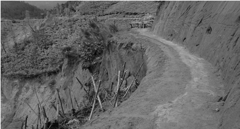
Gambar 5. Tanah Longsor di desa Ballatumuka akibat dari degradasi lahan.
