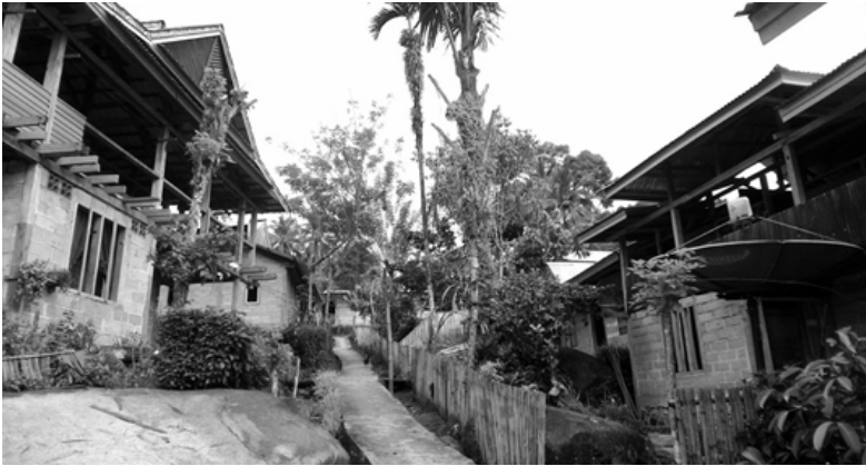
Gambar 14. Suasana desa Tabulahan. Tampak rumah penduduk yang mendapatkan program bedah rumah
