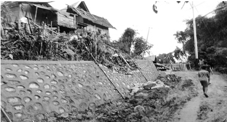
Gambar 13. Pembangunan talud dan proyek pengerasan jalan di desa Ballatumuka
