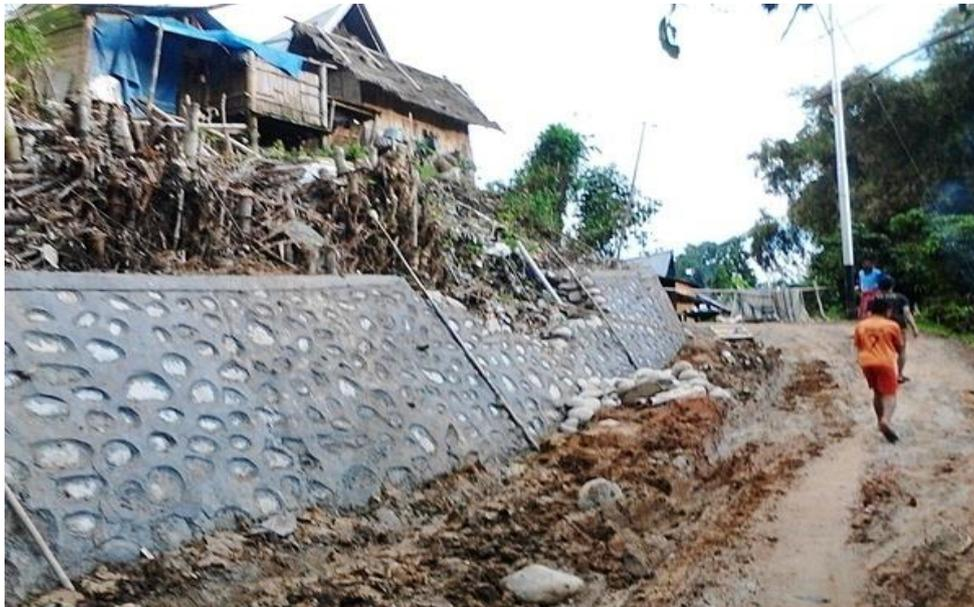
Gambar 16. Pembangunan talud dan proyek pengerasan jalan di desa Ballatumuka
