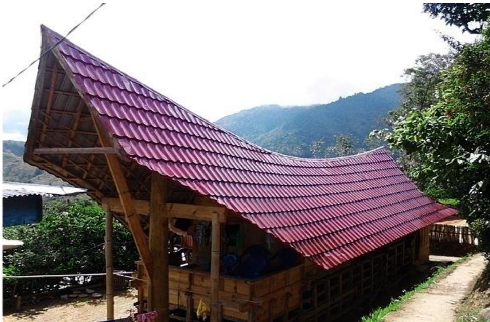
Gambar 12. Rumah banua yang telah berganti dengan atap baru dari rangka baja ringan
